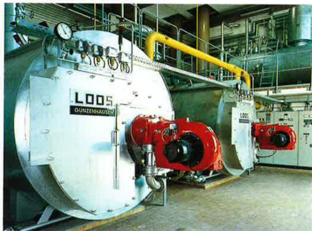
**Exemple de livraison:** 2 chaudières de moyenne puissance UNIVERSAL, dans la chaufferie centralisée d'un hôpital pour la cuisine, la blanchisserie et la stérilisation.
