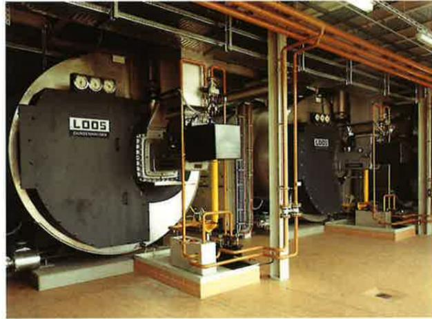
Exemple de livraison 2 chaudières UNIVERSAL montées dans une centrale de chauffage urbain.
