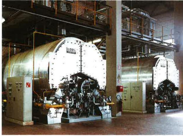
Exemple de livraison: 2 chaudières à double tube-foyer chauffant et produisant de la vapeur pour l'industrie automobile. Puissance totale de l'installation: 30 000 kW, 13 bar, 194 °C. Brûleur: fioul domestique/gaz naturel.
